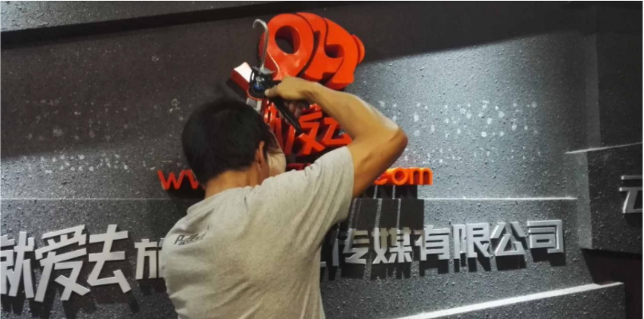
精工字：不锈钢字采用 304#不锈钢板切割、打磨、抛光、电镀等工序精致而成，镜面亮度可达 18K-24K 不锈钢本色镜面褪色，字形美观大方，一般用于高层办公楼层电梯的导示文字，酒店的门牌等，字的大小可做到 3CM-20CM 不锈钢字采用 1.0MM-2.0MM 304#不锈钢板切割、围立体边、打磨、抛光、（电镀、烤漆）等工序精致而成，镜面亮度可达 18K 字形美观，立体感强、牢固度高。不锈钢字制作材质：304#和 201#不锈钢字材料厚分为 1.0mm-2.0mm 不锈钢字一般应用于公司的标识标牌 logo 墙、户外广告、不锈钢字加工制作，精品不锈钢字加工制作、不锈钢字加工制作等。发光类的广告字有树脂字，迷你字，亚克力无边字、吸塑字等等。成功的平面广告在画面上应该有非常强的吸引力，彩色的科学运用、合理搭配，图片的准确运用并且有吸引力。官渡区制作广告安装
